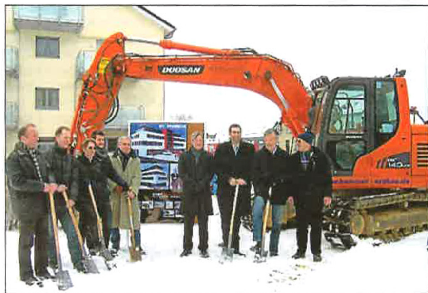
Vor wenigen Wochen gaben die Bauherren, die zukünftigen Nutzer des Gebäudes und Bürgermeister Heep mit dem ersten Spatenstich den offiziellen Startschuss für den Neubau des MVZ. (Foto: Henche)
