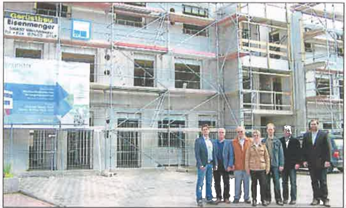
Der Neubau des MVZ macht große Fortschritte, davon konnten sich (von links) Daniel Ebert, Erhard Ebert, Karl Dienst, Bettina Stahl, Andreas Dienst, Bürgermeister Manfred Heep und Alexander Emmerson überzeugen. (Foto: Henche)
